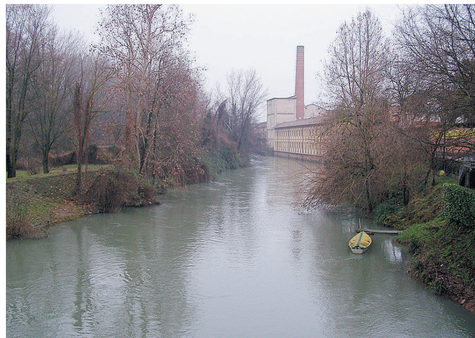
Il canale scolmatore che rischia di diventare poco più di una roggia
